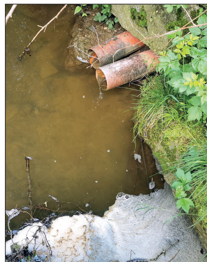
Abb. 3: Eines der vielen hochwasserver-schlimmernden Drainagerohre – hier 2024 in Aubach – sie tragen außerdem auch verunreinigtes Wasser in die Bäche.
