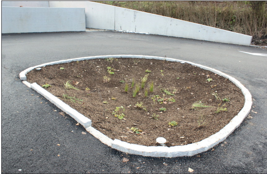
Abb. 19: Sickermulde mit Kombination aus Pflanzung und Ansaat, ein Monat nach Herstellung, im November 2012
