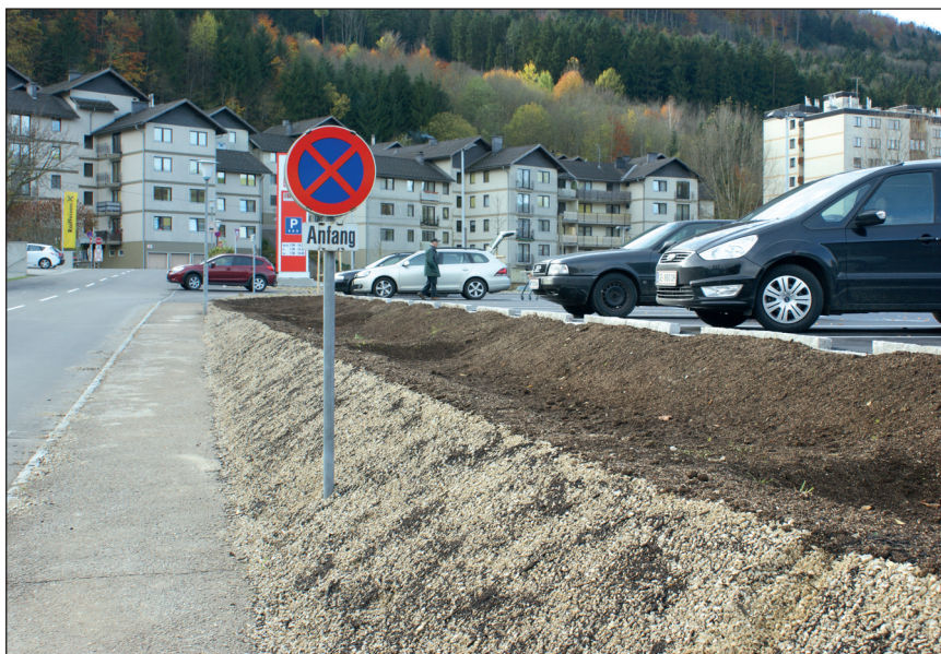
Abb. 12: Abgetreptte Mulde bei fallendem Gelände mit Zwischenbermen
