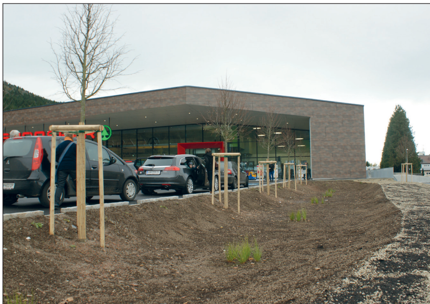
Abb. 11: Ausgerundetes Trapezprofil als einfachste geometrische Form, nach der die Mehrzahl der Sickermulden gebaut werden
