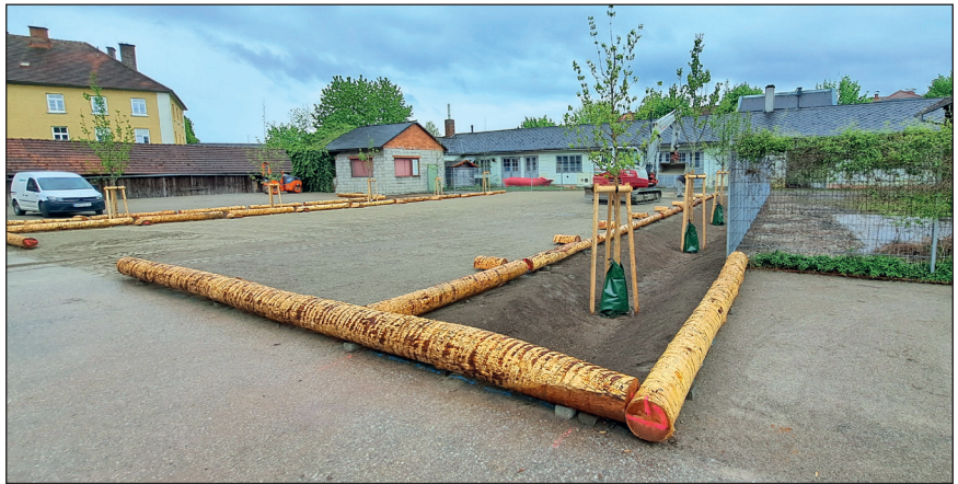
Abb. 7: Park & Work-Parkplatz Steyr Tabor, April 2024, Zustand nach Fertigstellung: Die Grünflächen wurden durch Lärchen-Rundstämme geschützt, die Bäume auf der Sohle der Mulde gepflanzt mit Dreipflockverankerung, Schilfmatten als Stammschutz und Gießsäcken.
