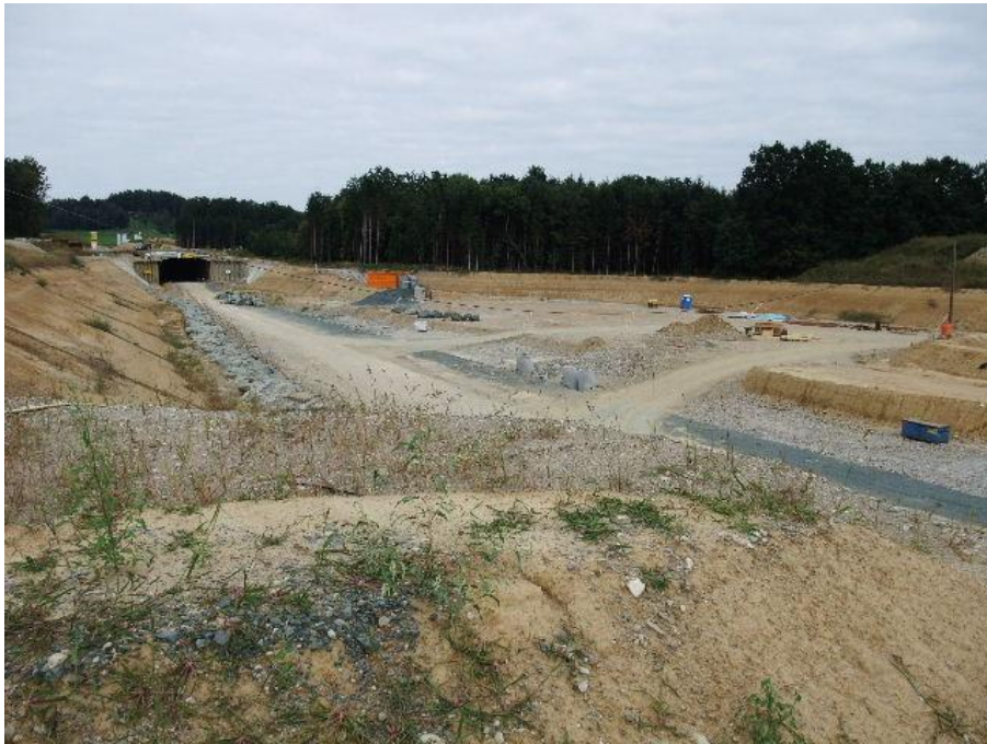
Abb. 3: Blick auf die Fundstelle nach Abschluss der Grabarbeiten
