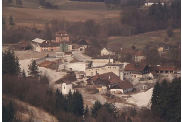
Abb. 13: KAMIG-Werksanlage in den 1980-er Jahren
