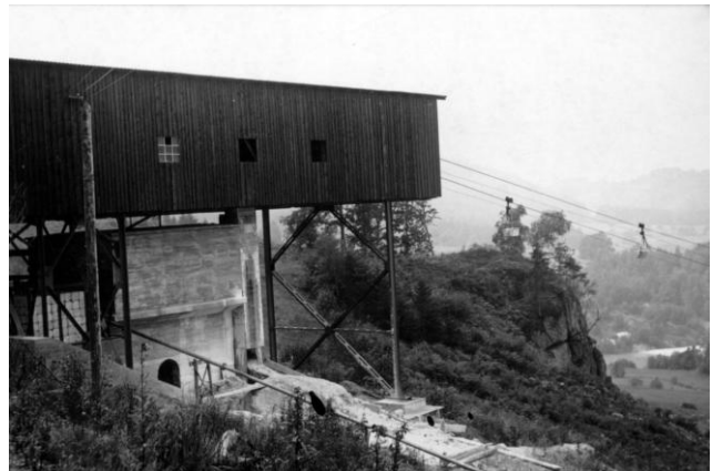
Abb. 9: Endstation der Haldenbahn, das Gebäude besteht noch heute
