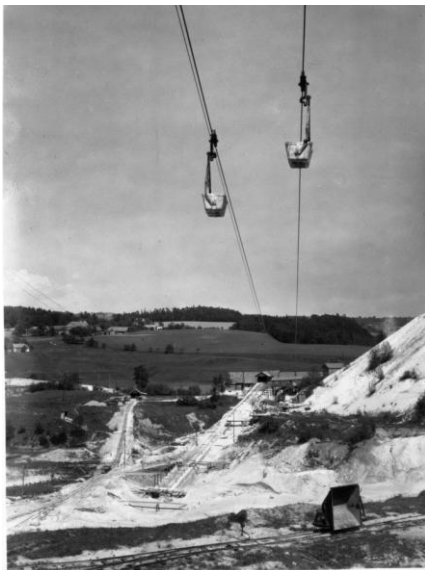
Abb. 10: Werksansicht 1948, Christinenschacht im Bau
