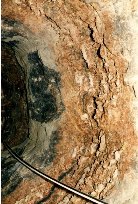
Abb. 8: Aufgelassene Strecke im Backhaus-Horizont mit sulfatischen Einlagerungen, 1986.
