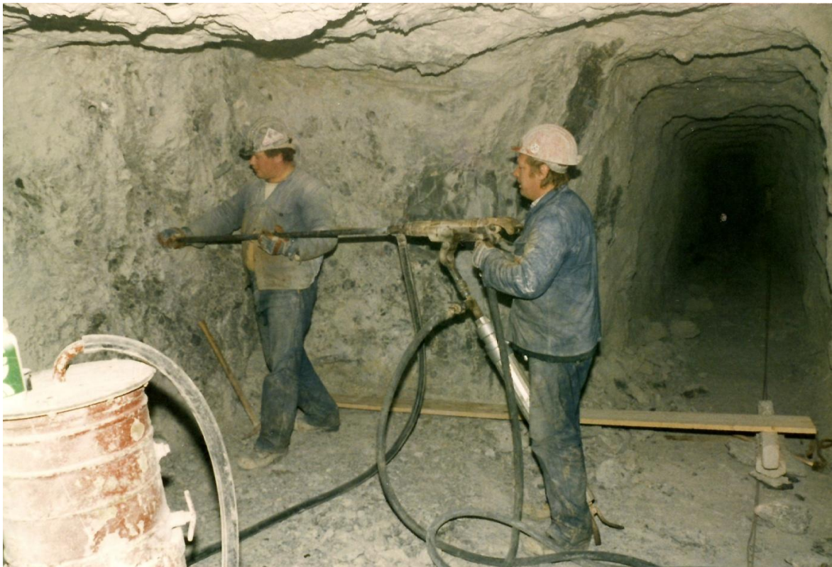
Abb. 13: Tiefenwerk Elisabeth 22, Aufbrucharbeiten für Hornstätte, 1986.
