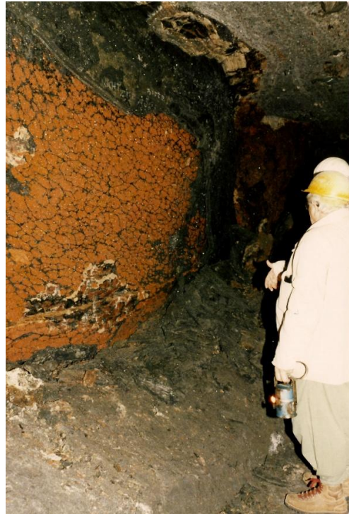
Abb. 12: Sicherungswerk III, „Rote Wand“ - (bituminöser Anhydrit) 1986.
