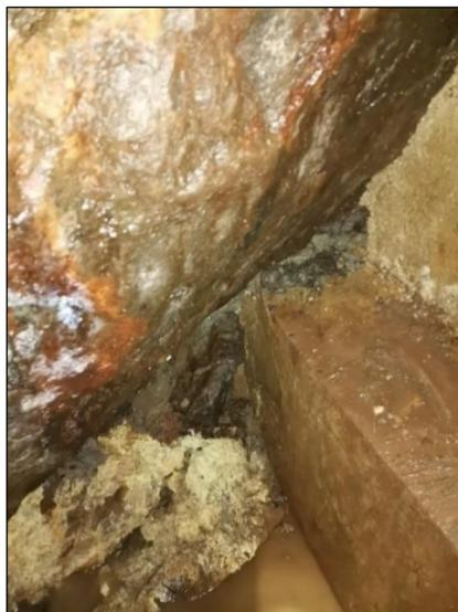
Abb. 10: Glanzschiefer, kleiner Aufschluss an der rechten Sohle am Übergang von der Betoneinfassung zum nicht verbauten Teil der Stampfer Kehr. Im linken oberen Bildbereich ist die massive Eisensulfidbank zu sehen. Der Glanzschiefer, hier schwarz, ist teilweise von Oxidationsüberzügen der Sulfidzersetzung bedeckt (2022).
