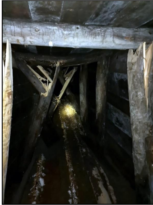
Abb. 5: Wirkung des Bergdruckes auf alte Strecken: Hier im Kaiser Leopold Hauptschachtricht, Ischler Salzberg 2022, Foto P. Arthofer
