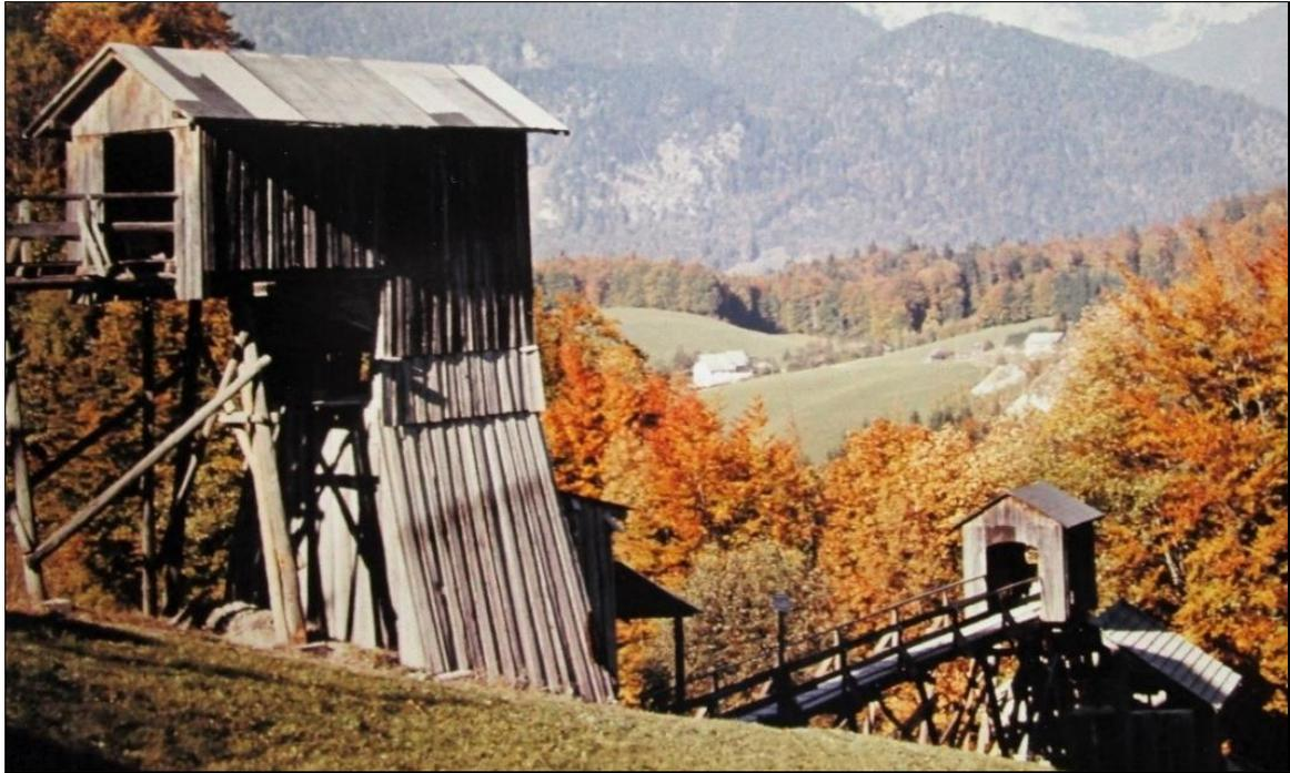
Abb.18.: Gipsbergbau Obereck, Brecher und Füllort der obertägigen Anlagen um 1960.
