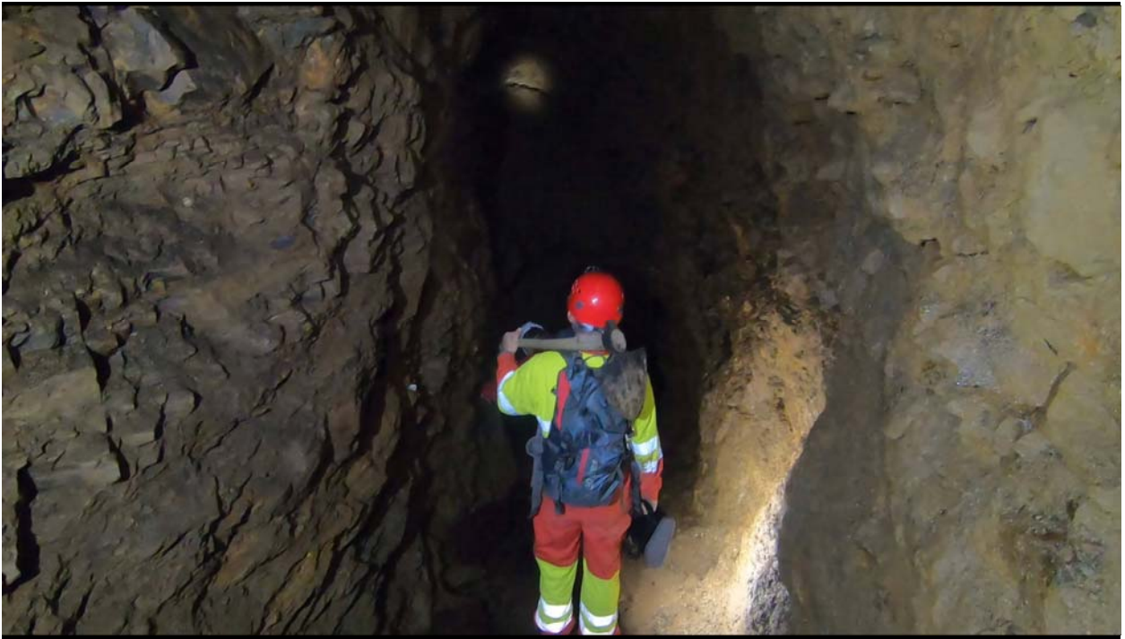
Abb. 9.: Abbaubereich mit gut sichtbarer Schichtung des Erzlagers am linken Ulm. Foto: D. Pongratz, Wolfsberg
