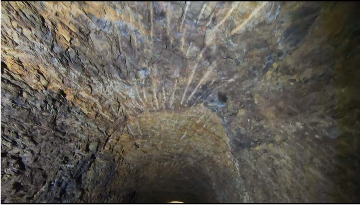
Abb. 7.: Schrämmspuren an der Firste. Foto: D. Pongratz, Wolfsberg
