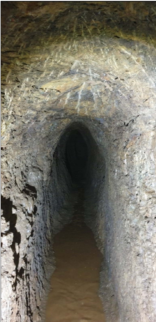
Abb. 5.: Stecke mit sichtbaren Spuren des Vortriebes per Hand.
