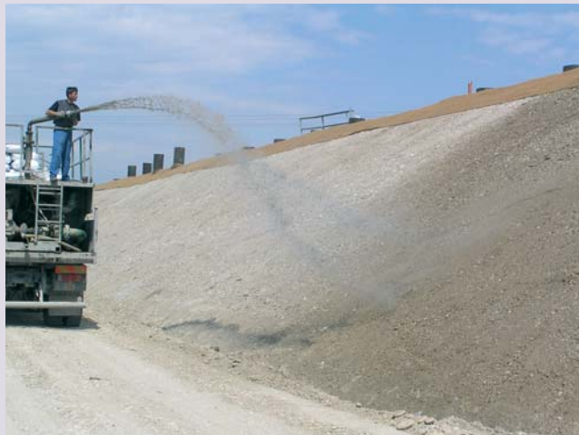
Foto 7: Begrünung einer Böschung mittels Nassspritzverfahren
