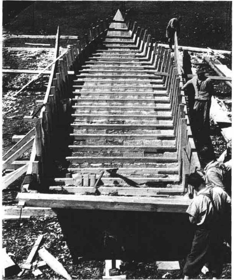
Abb. 7 Der Mutzen wird seitlich hochgewunden und unterstellt. Am Bild erkennt man, daß der Seim der Länge nach angestückt ist. (Schiffung).
