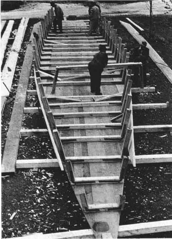
Abb. 3 Der Schiffboden ist grob zusammengefügt, die Kipfen (früher waren es Kipfenpaare) werden eingepaßt. Links und rechts vom Schiffskörper liegt der Seim.
