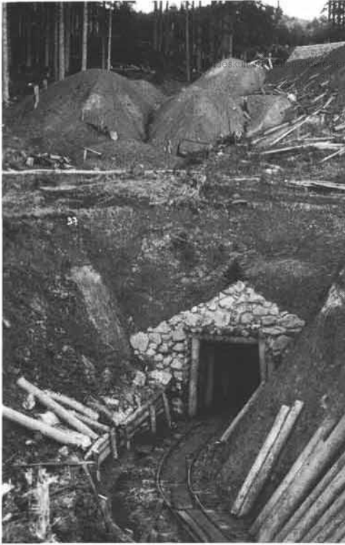
Abb. 3: Unterlaussa. Steinkohlenbergbau unterm Hochkogel, Grubenfeld „Josef“ im Sandl. Mundloch des Barbara-Stollens (?) mit Geleise der Grubenbahn; darüber Halden beim Karl-Stollen. Aufnahme wahrscheinlich im Herbst 1934. Unbezeichnete und undatierte Fotografie im Besitz von H. J. Köstler.
