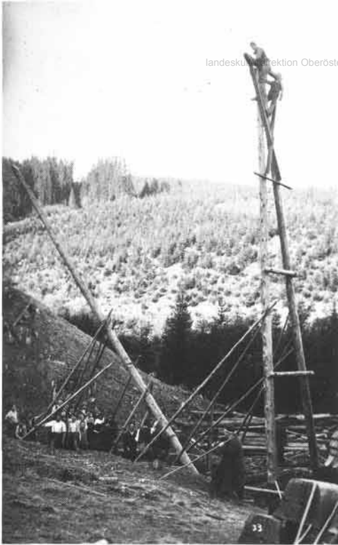
Abb. 6: Unterlaussa. Neubau der Seilbahn zwischen dem Steinkohlenbergbau unterm Hochkogel (Grubenfeld „Josef“ im Sandl) und dem Ort Unterlaussa. Aufnahme wahrscheinlich im Herbst 1934; vorne rechts: Betriebsleiter Josef Koestler (mit Bergstock). Unbezeichnete und undatierte Fotografie im Besitz von H. J. Köstler.
