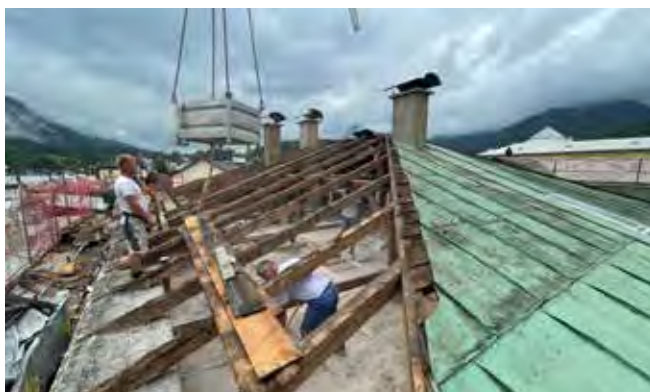
Instandsetzungsarbeiten am Dachstuhl
