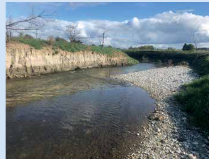
Abb. 2: Ungesicherte Steilufer, überströmte Kiesbänke und Flachwasserbereiche (Foto W. Lauber)
