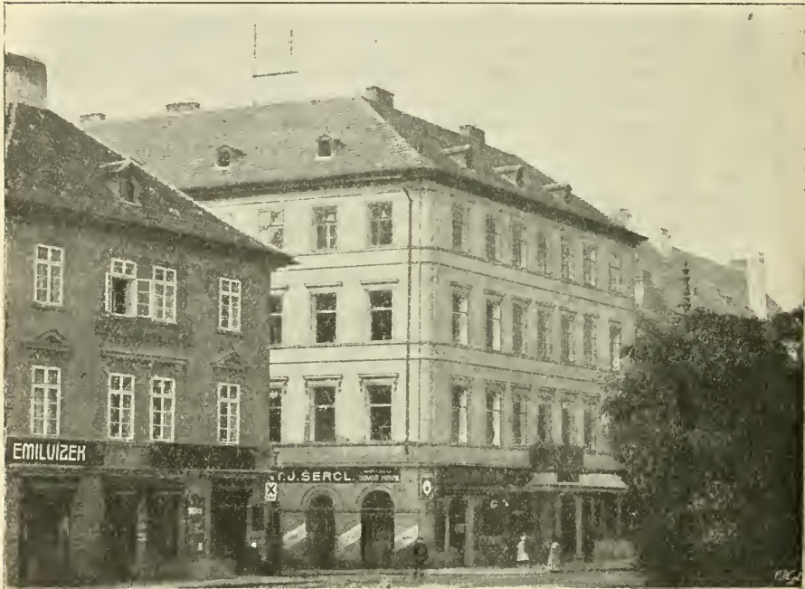
Abb. 1. In dem ersten Stocke dieses Hauses (Karlsplatz Nr. 3, Haus Šercl) war das pflanzenphysiologische Institut in den Jahren 1886 bis 1898 untergebracht.
