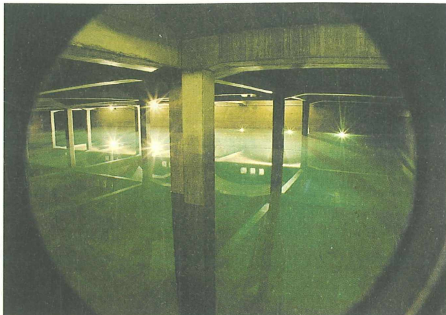
Blick in das unterirdische Trinkwasser-Reservoir im Mönchsberg, das ausnahmsweise zu besichtigen ist.
