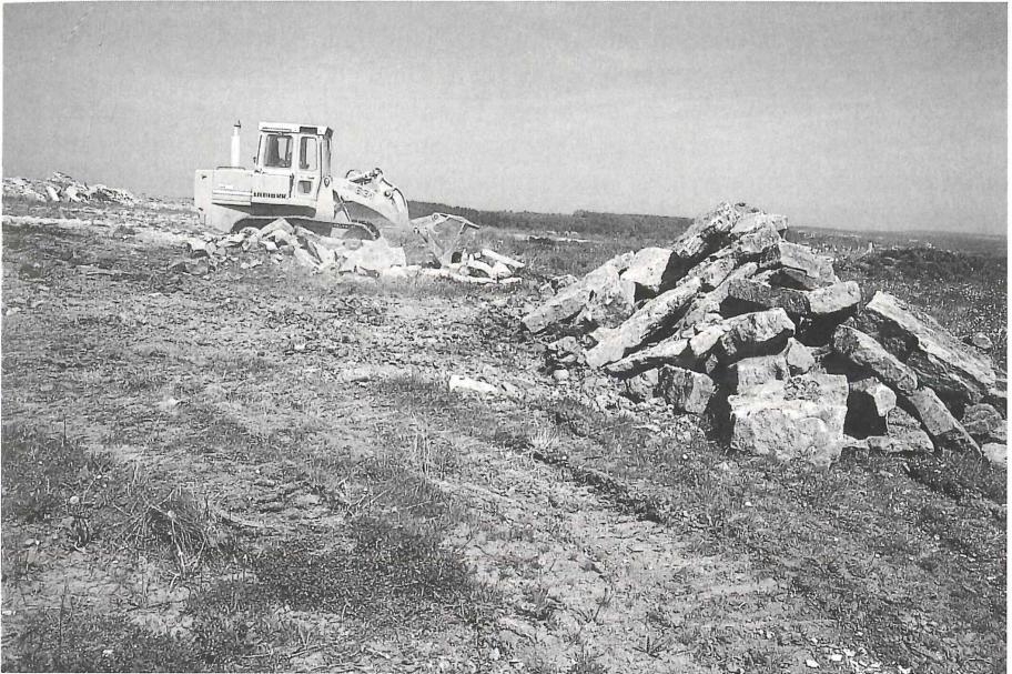
Abb.15. Neu-Anlage von künstlichen Steinriegeln auf einer Erddeponie: Planierdrape beim Formen von zwei Steinhäufen aus Steinplatten-Material (Unterer Schwarzer Jura) von einer Baugrube. > 20 Jahre besetztes Raubwürger-Winterwohngebiet angrenzend. „Hummelberg-Dorfbach“, Vorland der Südwestlichen Schwäbischen Alb. Foto 15.5.1997.
