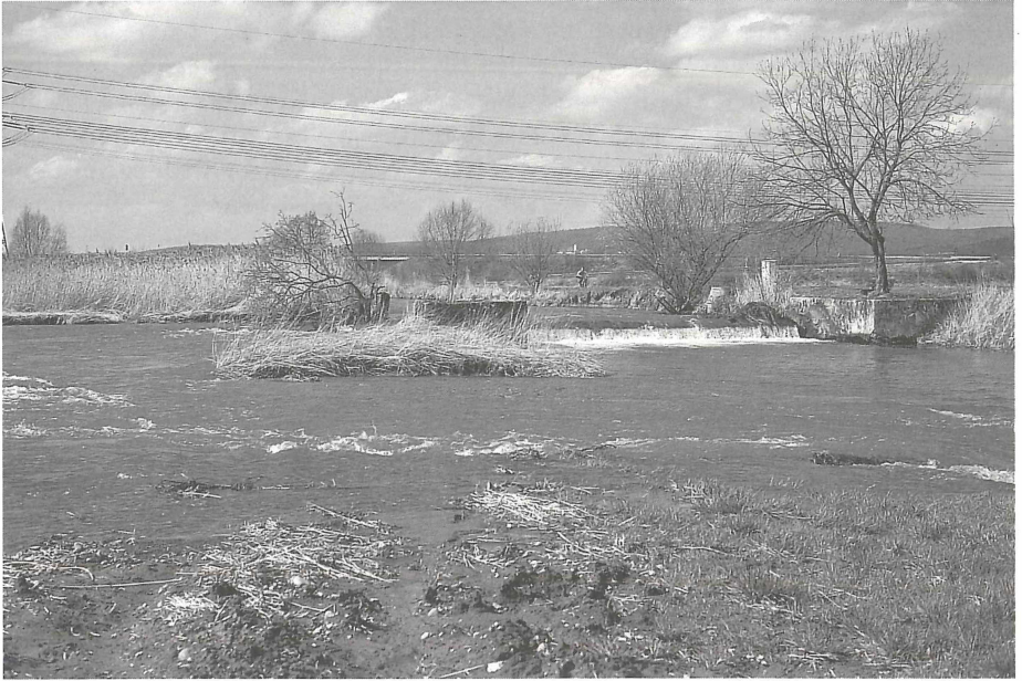
Abb. 2. Gebrochener Damm an einem Wehr (Bildmitte) und Mäander im Maisfeld (links). Blick flussauf.
