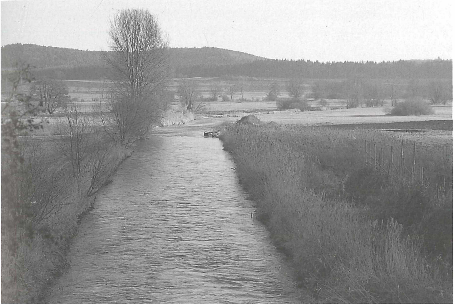
Abb. 3. Kanalisierter Fluß im Abschnitt 1, 1988. Blick flußab.
