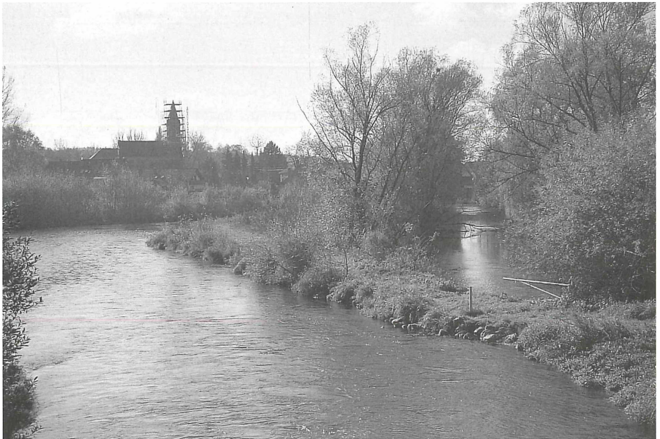
Abb. 10. Künstliche Flußschleife mit Sedimentfang, Abschnitt 4 (links) und der zum durchströmten Altarm umgewandelte Kanal, Abschnitt 5 (rechts), 2001. Blick flußab.
