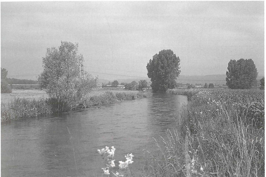
Abb. 7. Kanalisierte Radolfzeller Aach, Abschnitt 2, 1986. Blick flussauf.
