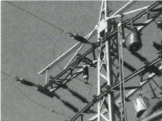
**Abb. 11:** Sitzbretter sind eine willkommene Teillösung. Das mittlere Seil ist aber immer noch gefährlich (Erdschlussgefahr mit Traverse). Die DIN VDE-Bestimmung 0210 wird im Hinblick auf Neubauten nicht erfüllt, da hier Sitzgelegenheiten (Kettenglieder aus Metall) nahe der Leiter geschaffen werden.
