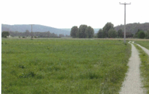
Abb. 3: Die mangelnde Bereitschaft der EVU dokumentiert dieses Bild vom Unglücksort in Inching (Abb. 2). Nur der Unglücksmast selbst wurde mit Abdeckhauben entschärft, während alle anderen, ebenso gefährlichen Masten dieser Leitung ungesichert blieben. Eigentlich dürfte es solche unentschärften Masten mit Stützenisolatoren in Bayern gar nicht mehr geben: Seit 1986 besteht die Selbstverpflichtung der Energieversorgungsunternehmen, solche Masten zu entschärfen. Und seit 2002 ist ihre Entschärfung durch § 53 Bundes-Naturschutzgesetz zwingend vorgeschrieben. Gerade Stüttermasten, wie die im Bild, lassen sich am einfachsten und am wirkungsvollsten entschärfen. Dafür wurden schon vor über 20 Jahren die Abdeckhauben entwickelt. Inching, Kreis Eichstätt, Bayern, 19.10.2005. Foto: U. Lanz
