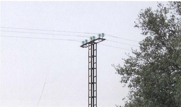
Abb. 4: Gefährlicher Stahlgittermast mit sehr kurzem Querträger und kurzen, paarweise angeordneten Stehisolatoren. Dieser Masttyp wurde bereits vielerorts durch neue Stahlbetonmasten mit längeren Querträgern ersetzt, die aber ebenfalls kurze Stützenisolatoren tragen. Foto: Gerd-M. Heinze
