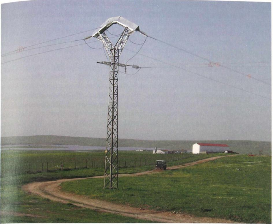
**Abb. 10:** Schutzhauben aus Blech und abgehängte Isolatoren sowie Spiralen an den Leiterseilen sollen Stromschläge bzw. Drahtanflüge verhindern. Foto: Gerd-M. Heinze
