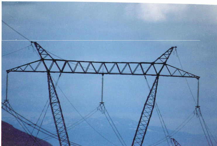
Abb. 2: Mast einer Hochspannungsleitung mit zwei dünnen, erhöht angebrachten Nulleitern über den Stromleitern. Diese 2. Ebene erhöht das Kollisionsrisiko für Vögel erheblich. Nördlich von Polashoefen, 24.06.05. Foto: D. Haas
