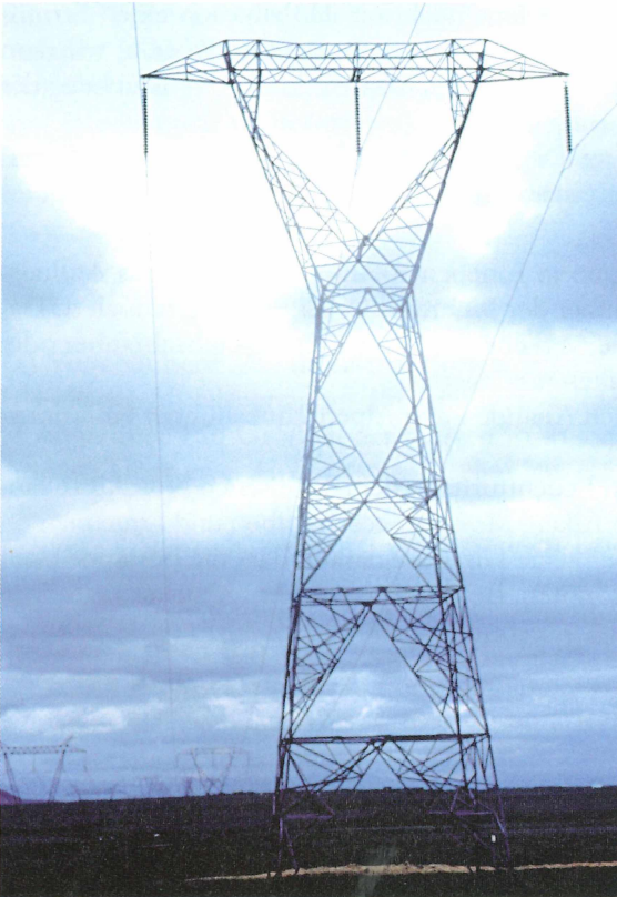
Abb. 1: Zwei Hochspannungsleitungen auf Island mit Einebenenordnung: die unter Spannung stehenden 3 Leiterseile sind in einer Ebene angeordnet. Bei der Leitung im Vordergrund wird auf Nullleiter völlig verzichtet. Das ist die Konstruktion mit dem geringsten Kollisionsrisiko für Vögel. Nördlich von Polakshoefen, Island, 24.06.05, Foto: D. Haas
