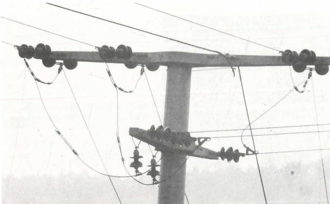
Abb. 27: Derselbe Mast wie Abb. 26 nach Umbau (Einbau eines zusätzlichen Hängeisolators). Der Mast wurde damit vorbildlich entschärft (nach Publikation im „Schwäbischen Tagblatt“ am 30. 10. 1975; Foto: D. Haas).
