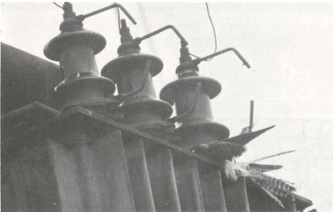
Abb. 29: An Schutzfunkenstrecken auf dem Trafo einer Maststation getöteter Turmfalk, mit Fang am unteren Blitzhorn. Oben hängt noch ein versengter Federrest. Darunter lag ein zweiter Falk im gleichen Verwesungszustand. 25. 9. 77 bei Riederich (Foto: D. Haas).
