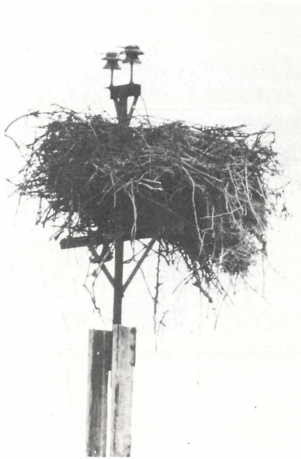
Abb. 74: Bewohntes Storchennest auf einem spannungslosen, andernfalls hochgefährlichen Mittelspannungsmast beim Bahnhof Arroyo-Malpartida, Prov. Caceres, Spanien, April 1978 (Foto: D. Haas).
