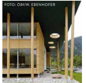
FOTO: ÖBF/W. EBENHOFER schnittelheizung im Stiftsgebäude des Forstbetriebs Kärnten-Lungau in Millstatt. Mit „grünem“ Strom aus dem ÖBF-eigenen Kleinwasserkraftwerk Kainischtraun wird auch das neue Betriebsgebäude der Fischerei in Pichl-Kainisch versorgt.
