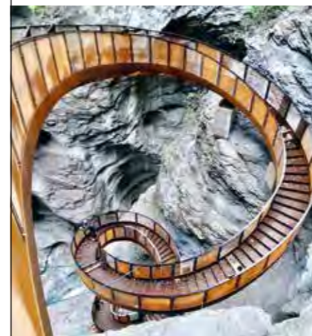
FOTOS: ÖBf/W. SIMLINGER; VISUALISIERUNG KRAFTWERK; ARCH. DI. PETER PRANTL; STADTGEMEINDE ST. JOHANN I. PONGAU/WIEHHAUSER
