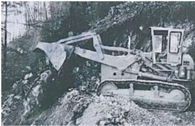
Abb. 12: Straßenbau mit Laderaupe (siebziger Jahre)
