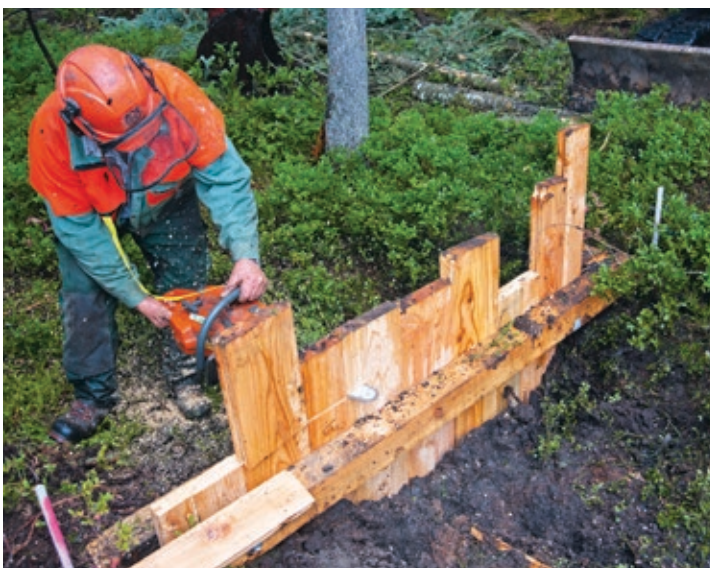
Ein Mitarbeiter der Österreichischen Bundesforste baut einen Damm aus Lärchenholz.
