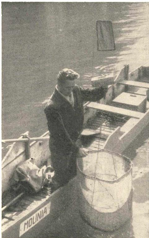
Abb. 2: Aussetzen eines Schwimmkorbes zur Strömungsmessung
