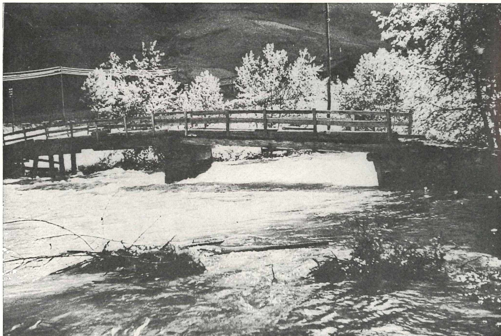
Ein guter Forellenplatz! Brücke über die Schwarzache (Deferegental)
