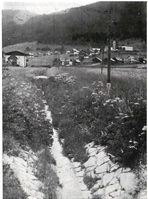
Flache Steinschale. Ufer im Zuwachsen. — Sowohl baulich als auch fischereilich sehr gut. Erbaut 1970.
