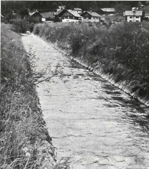
Hartes Ufer, Handarbeit, erbaut 1930. — Bis heute nicht der geringste Schaden. Fischereilich aber schlechthin eine Katastrophe.
