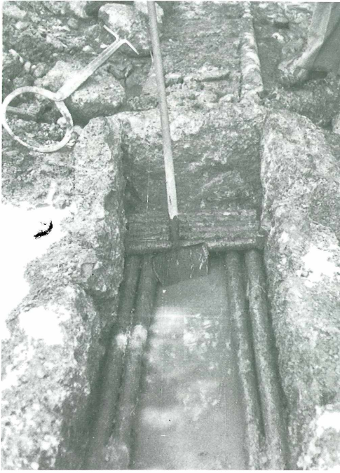
Im Bau befindliche Soblstufe mit Fischunterstand.
