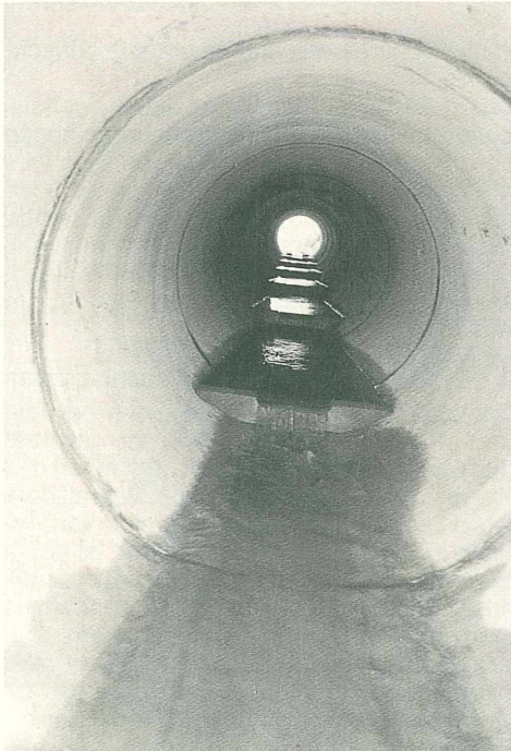
Kleine Stauhaltungen durch Einbau von Betonschwellen im Rohr
