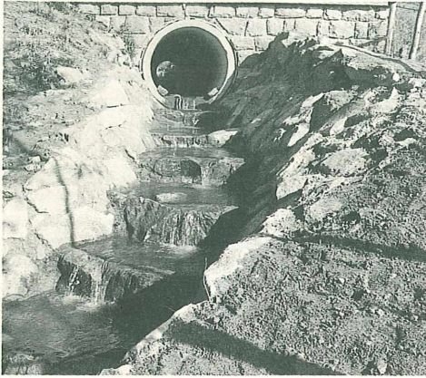
Überbrückung des Gefällsunterschiedes zwischen Rohrdurchlaß und natürlicher Bachsohle
