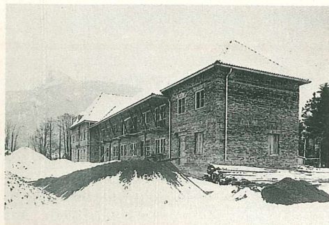
Bau des Institutsgebäudes, Scharfling 1952. (Aufn.: Hartmann, Mondsee)
