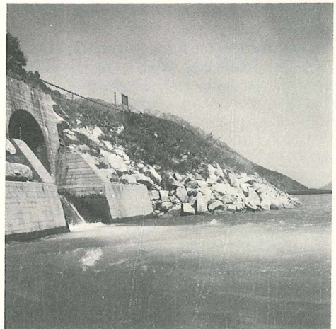
Abb. 2: Mündungsbereich einer (offensichtlich nur nach energiewirtschaftlichen Kriterien geplanten) Bachüberleitung am Schlegeisspeicher
