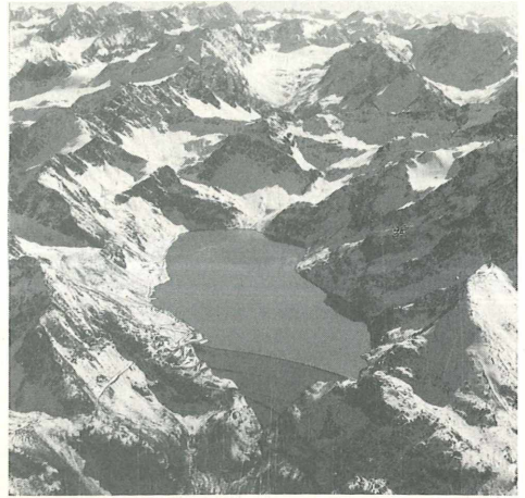
Abb. 1: Der Finstertaler Speichersee, ein Pumpspeicher mit 60 Millionen m 3 Nutzinhalt, im Hochgebirge Tirols Foto: Tiwag
