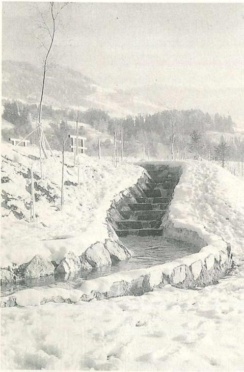
Abb. 1: Fischtrappe über den Begleitdamm des KW Urreiting, Salzach, Abstieg aus dem Oberwasser
