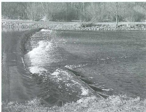
**Bild 1:** Isar-Schwelle mit Holzunterbau als Aufstiegshilfe
