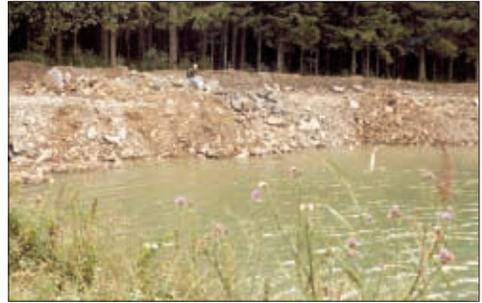
In den Anfängen gab es für Ausbaggerungen noch sehr wenig behördliche Auflagen. So mußten die fast senkrecht abgebaggerten Steilufer durch Schüttungen (schweres Gesteinsmaterial) in Flachufer umgebaut werden
