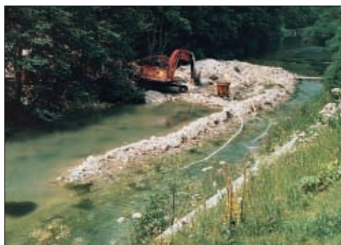
Abb. 2: Kanalbau – Der Anfang vom Ende
