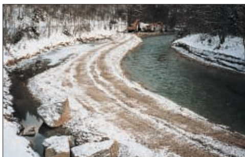
Abb. 5: Hochwasser Sanierung vom Flußbett aus
