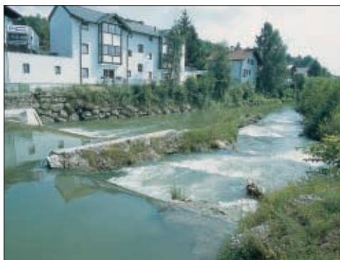
Fischaufstiegshilfe beim Schlauchwehr in Seekirchen. Foto: Dr. Jagsch
