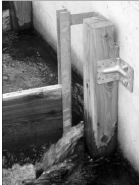
Foto 4: Beckenübergang, Neubestand, Detailansicht.
