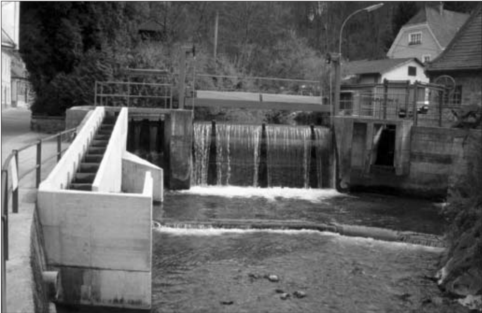
Foto 6: Gesamtansicht der neu errichteten Anlage
