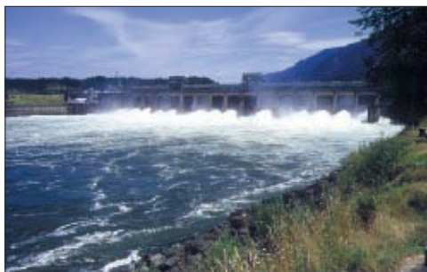
Ein Teil der riesigen Kraftwerksanlage des Bonneville Damms am Columbia River.
