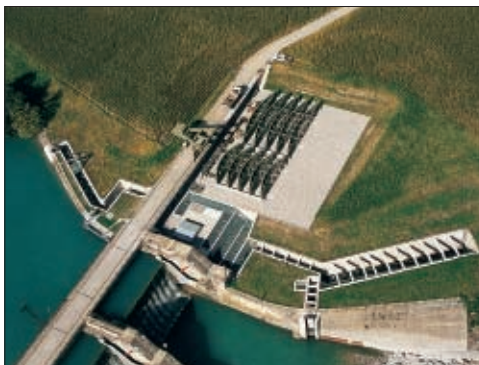
Der 180 m lange Fischpaß ist an der linken Wehrmauer in kompakten Schlaufen angelegt. Er überwindet eine Höhendifferenz von 12 m.
