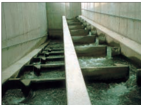
Der Vertical-Slot-Fischpaß (Schlitzpaß) hat den Vorteil, daß auch schwimmschwache Fischarten aufsteigen können.
