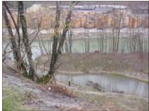
Schaffung eines Altarmes – einerseits Entlastungserinne bei Hochwasser – andererseits ein optimaler Fischeinstand
