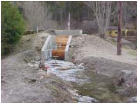
Fischleiter – oberer Teil, Einbindung in den Staubeereich Gußwerk mit regulierbarer Wassermenge
