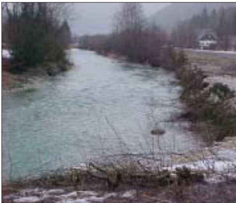
Hochwasserschutz – Einbau von Raubbäumen – idealer Fischeinstand im Bereich Gußwerk
