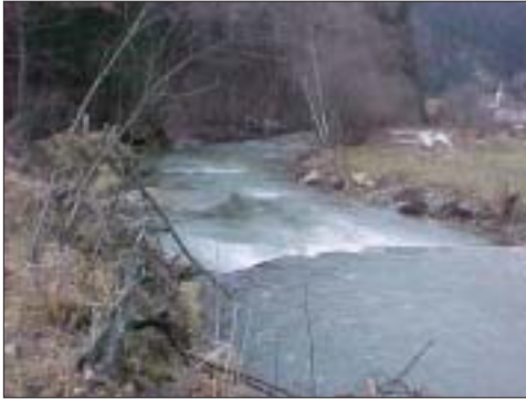
Natürlicher Verbau mit Steinen, Wurzelkörper und Raubbäumen im Nebengerinne Aschbach
