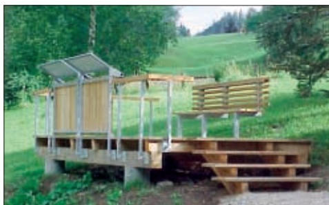
Die zweite Infoplattform: ein Steg mit zwei Infotafeln über dem Fließkanal der Fischzucht – interessant und lesenswert
