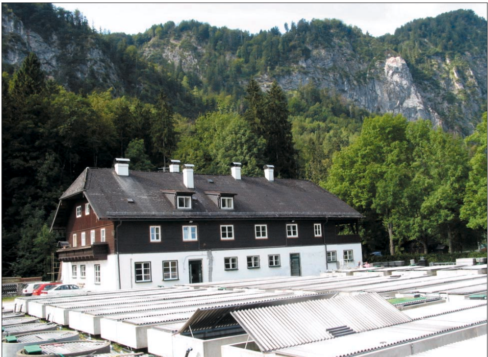
Abb.1: Ansicht der Fischaufzuchtanlage Kreuzstein, Aufzuchtbecken im Vordergrund
