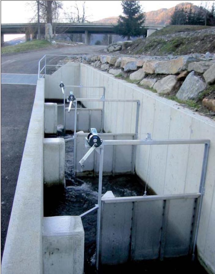
**Abb. 5:** Optionale Schlitz- in den drei Vorbecken. Die Umlenklöcke sind fix geschalt und haben praktisch keinen Einfluss auf das Fließverhalten bei hochgefahrenen Trennwänden
