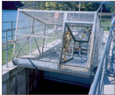
Abb. 20: Hochgezogene Kontrollreus am oberen Ende des Vertical-Slot-Fischpasses (Bild: Ruhlé)
