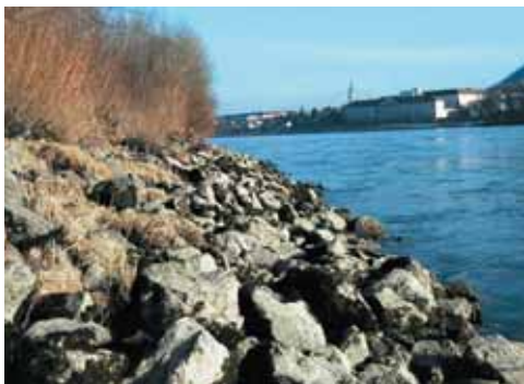
Vor dem Uferrückbau ...
